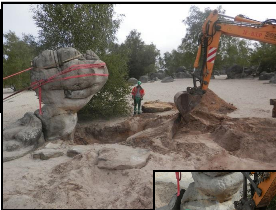
Chantier au Bilboquet
