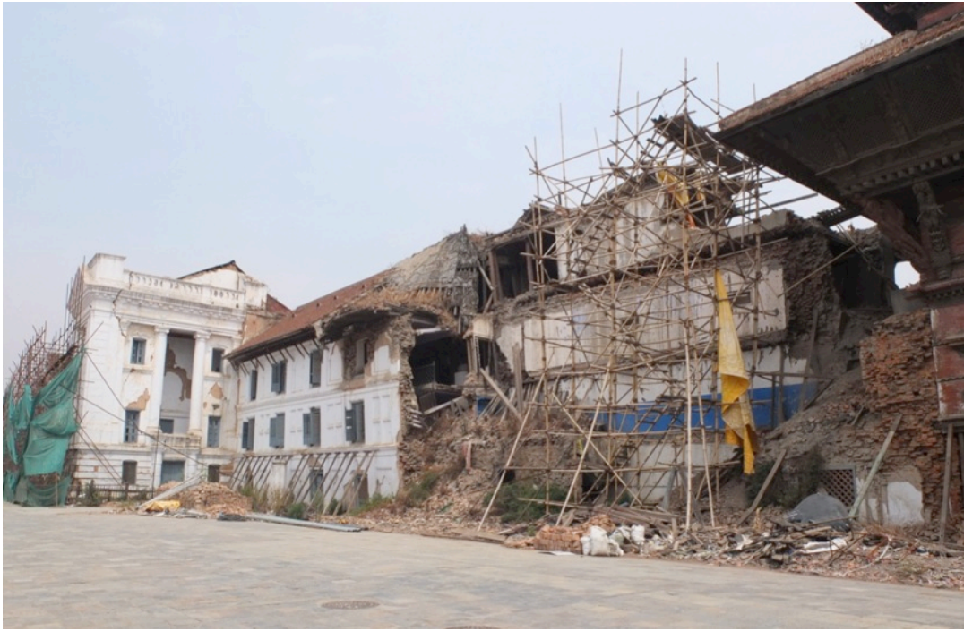
Dégâts à Katmandu
