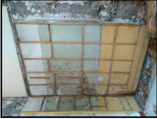
Mur du fond après enlèvement des placards
