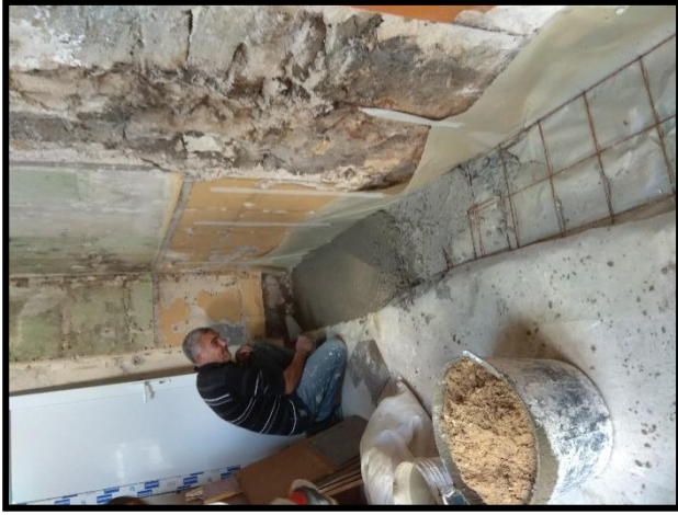
Exécution de la chappe de béton
