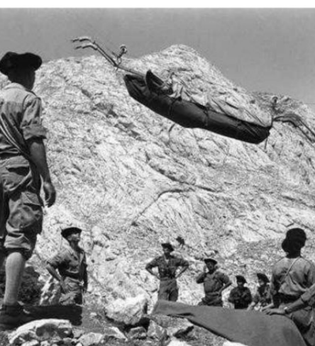
La perche Barnaud utilisée ici en téléphérique est un brancard suspendu léger porté à l'épaule par deux hommes
